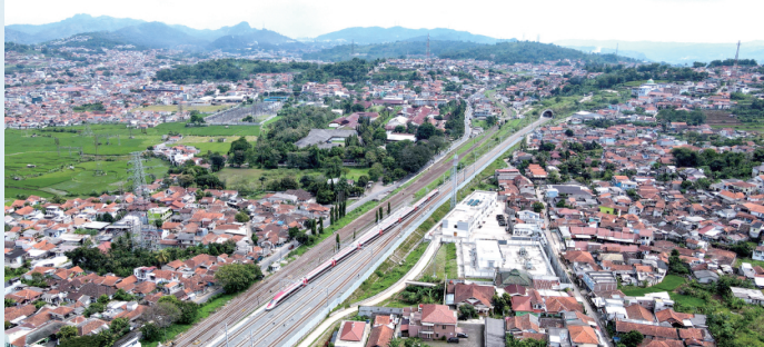
图为5月20日，在东盟国家印度尼西亚帕达拉朗，一列高速动车组列车行驶在雅万高铁沿线。目前，雅万高铁开通运营已满19个月，为区域经济发展注入强劲动力，为深化中国与东盟经贸合作发挥重要作用。
